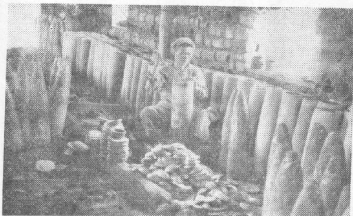
图 6 蒸馏罐的修理
