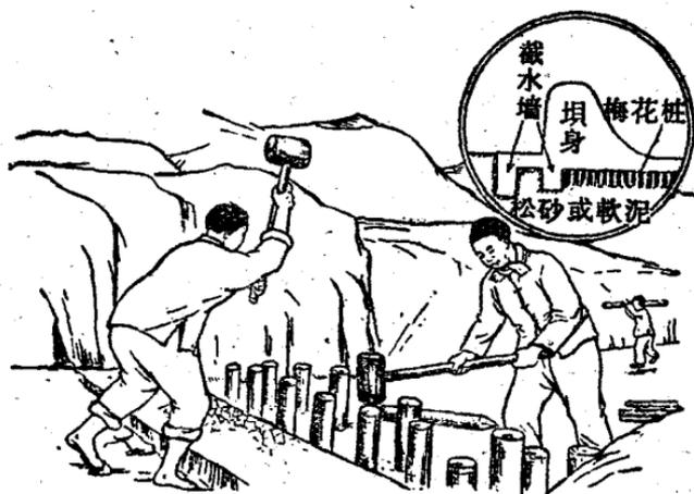
图4 拦河坝基础工程
